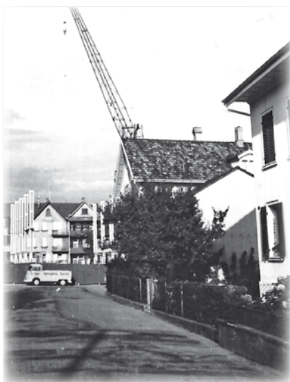
Die Stahlträger werden aufgerichtet (links).
